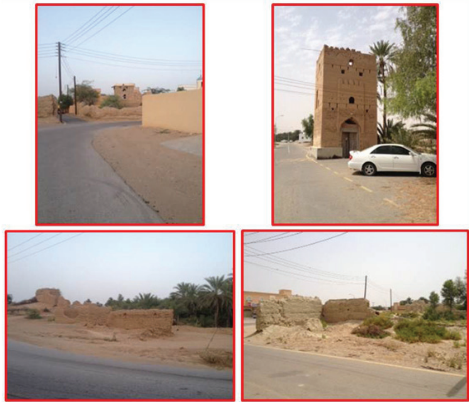
الشكل ١٧: تأثر بعض المباني القديمة بإنشاءات الطرق في منطقة جعلان بني بو حسن في محافظة جنوب الشرقية.
