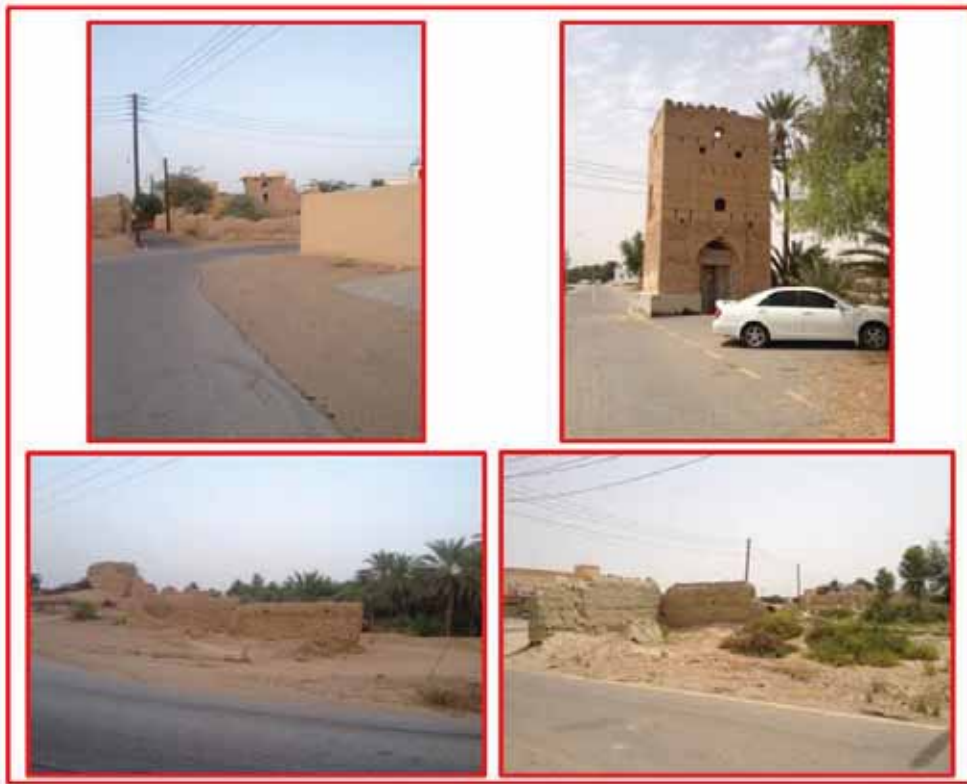
الشكل ١٦: تأثر بعض المباني القديمة بإنشاءات الطرق.
